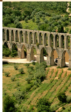
Aqueduto dos Pegões Altos Pegões Altos Aqueduct
